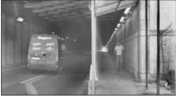
Il tunnel pedonale che sostituisce quello di Borgo Incrociati
