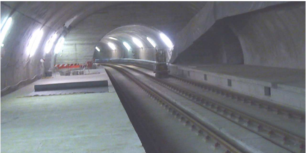
Lo scatolato in "grezzo" della futura Stazione di Corvetto (Novembre 2010)
