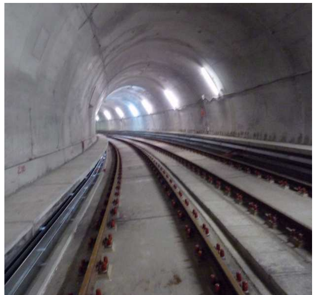
Il tunnel nel tratto verso Brignole (Novembre 2010)
