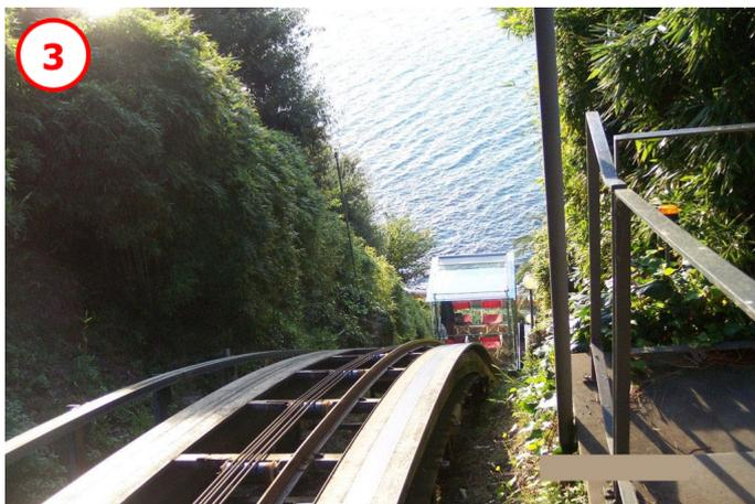
Questo tipo di soluzione ha dunque ispirato con i dovuti dimensionamenti ed adattamenti l'impianto di Quezzi, che costituisce il primo esempio di ascensore a piano inclinato ad uso pubblico con pendenza variabile. Anche qui abbiamo una via di corsa di poco più di 100 metri con cambio pendenza e anche qui troviamo una bella cabina panoramica tutto cristallo.
