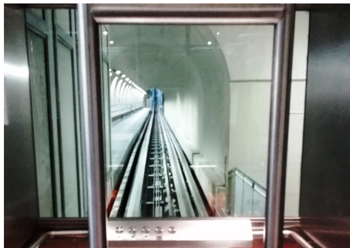
Zoom sui binari nel tratto orizzontale
