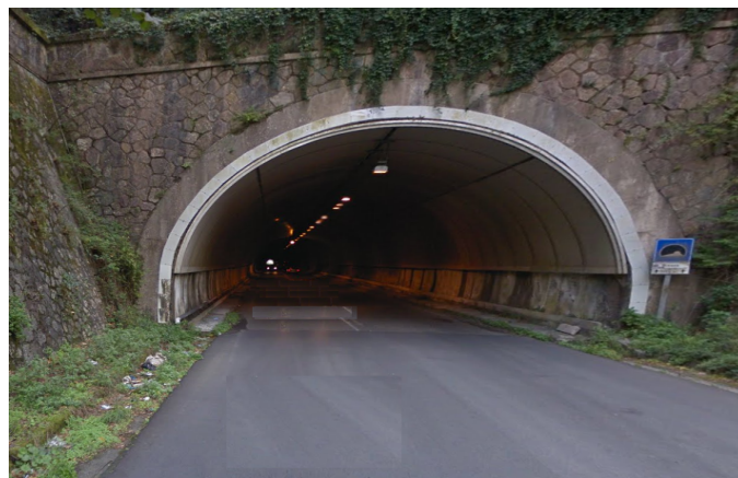
La galleria di accesso alle Cinque Terre
