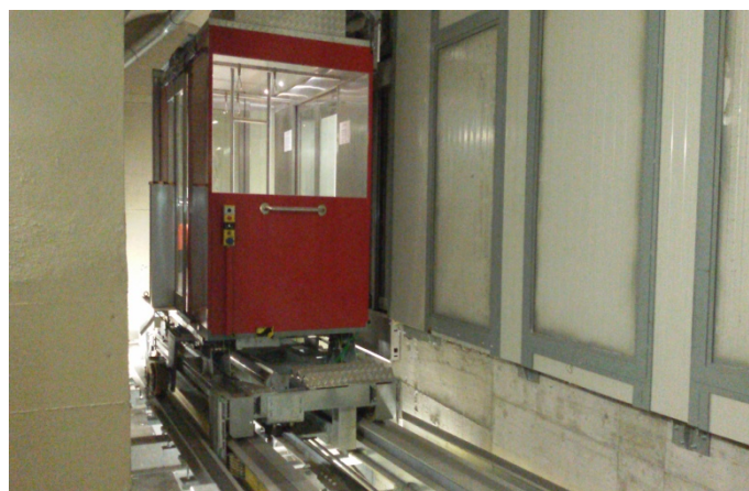
Cabina nel tratto orizzontale del percorso
