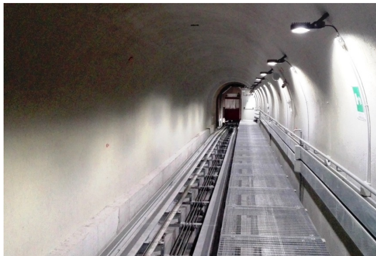
Cabina dell'ascensore durante il percorso
