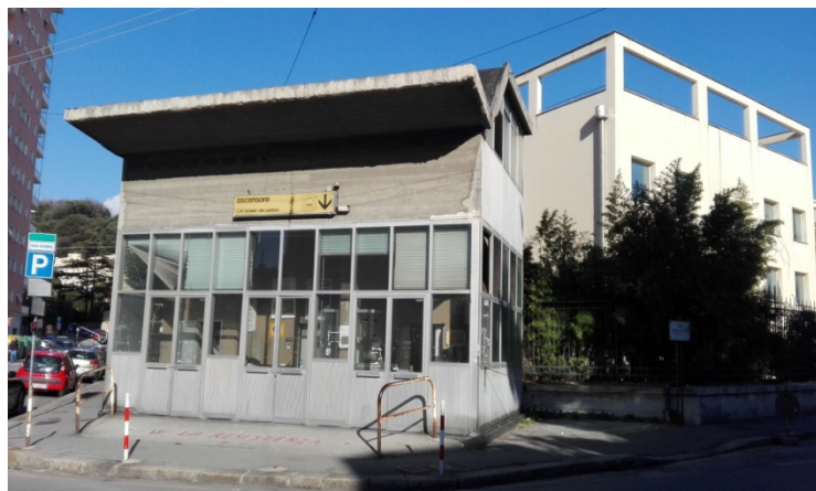
Locale di accesso all'ascensore
