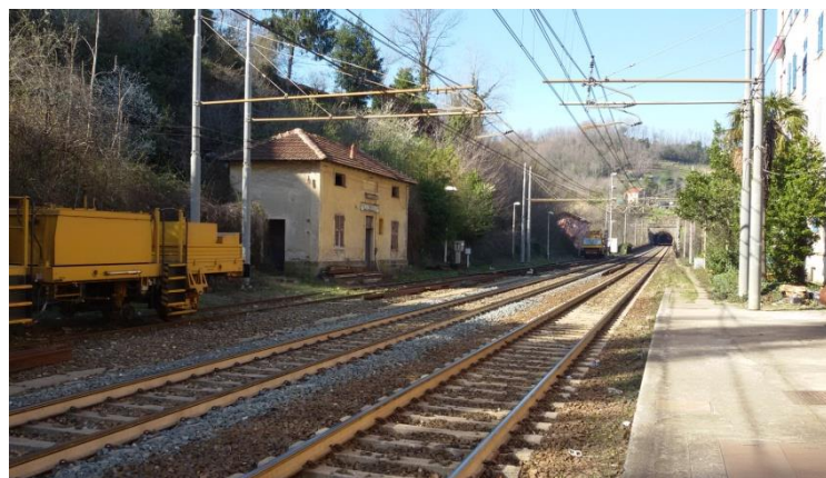
Panoramica stazione - mezzi di cantiere
