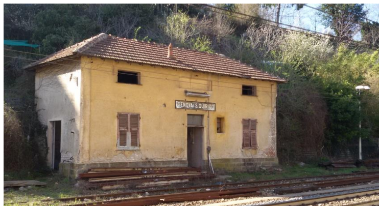
Fabbricato tecnico lato monte
