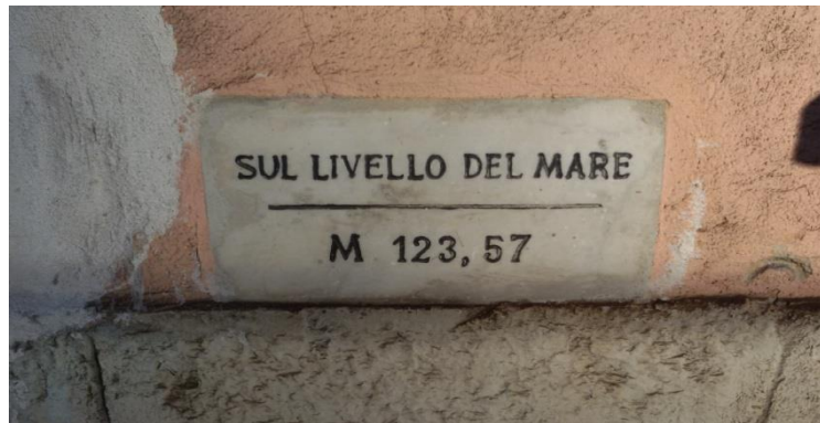
Targa altitudine su fabbricato viaggiatori di stazione
