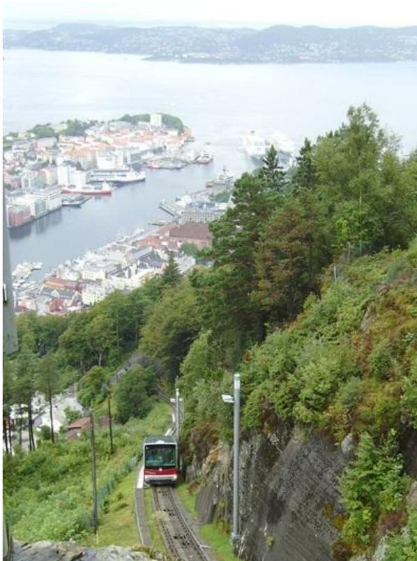
Si tratta di un classico impianto a fune a binario unico con raddoppio a metà percorso, su cui viaggiano due vetture con tetto interamente vetrato sostituite l'ultima volta nel 2002 con mezzi prodotti da **Gangloff**. A bordo di ciascuna vettura c'è un operatore che ha un unico posto guida-controllo posto verso monte.
